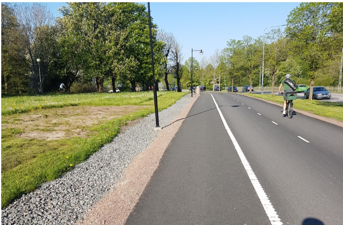
Figur 5. Exempel på makadamdike. Bild: Dämmningsverket.
