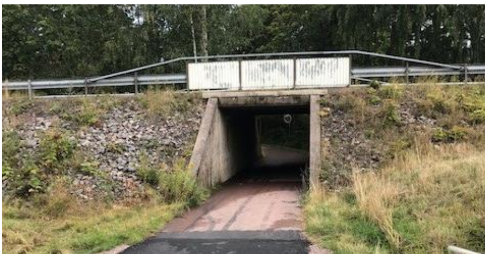
Figur 5. Befintlig tunnel för gående och cyklister under Mörmovägen.
