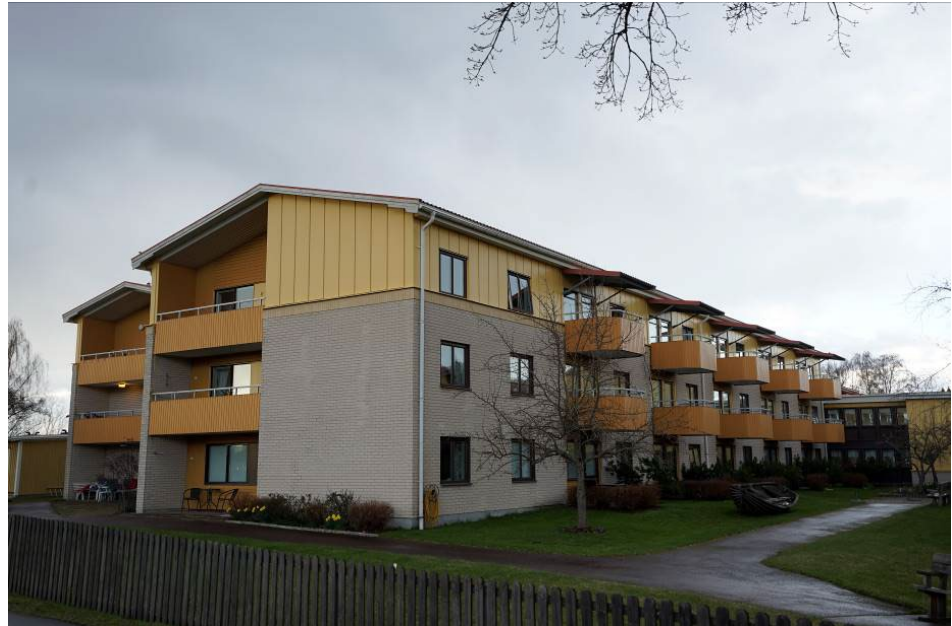
Del av Gunnarskärsgården med den påbyggda tredje våningen från 1990-talet
