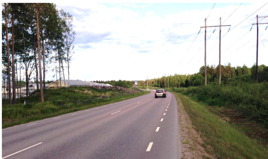
Figur 5. Befintlig kraftledning längs Lövnäsleden på Annebergssidan.
