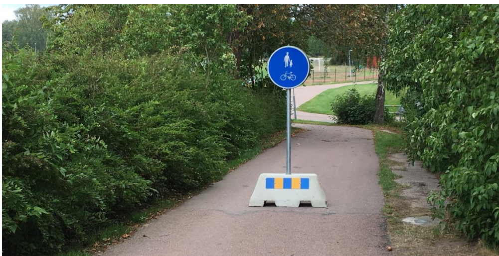
Figur 16. Olämpligt hinder som bör tas bort. Den ökar risken för tillbud även om den har reflexskylt. Breda betongsuggor som denna begränsar den fria bredden
