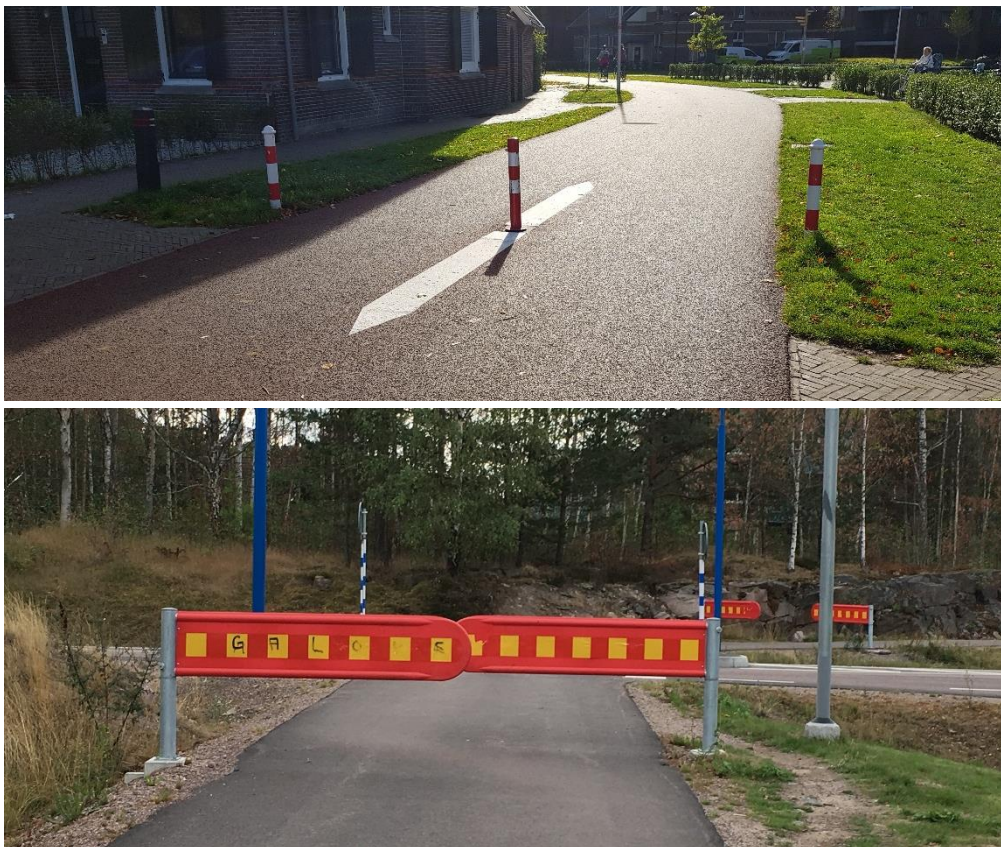
Figur 15. Pollare (överst) är ofta en bättre åtgärd än fållor (nederst) avseende cyklisters trafiksäkerhet och framkomlighet. Till höger om fållorna syns hur cyklister cyklar utanför dem.
